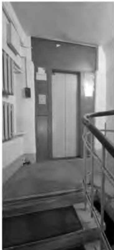
Лифт и лестничная клетка 1-го этажа
